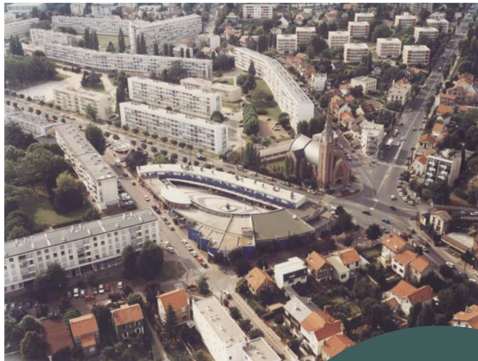
► Vue aérienne du centre commercial des Blagis en 1992.
