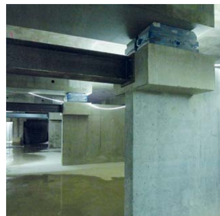
Les boîtes à ressorts posées au niveau du plafond du parking. Installées entre deux poutres, elles supportent les 1100 tonnes du bâtiment.
