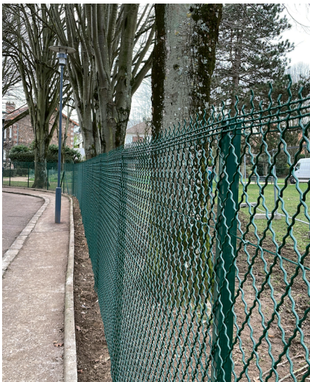
Pose d'une nouvelle clôture rue de Seignelay et plantation d'une nouvelle haie.
