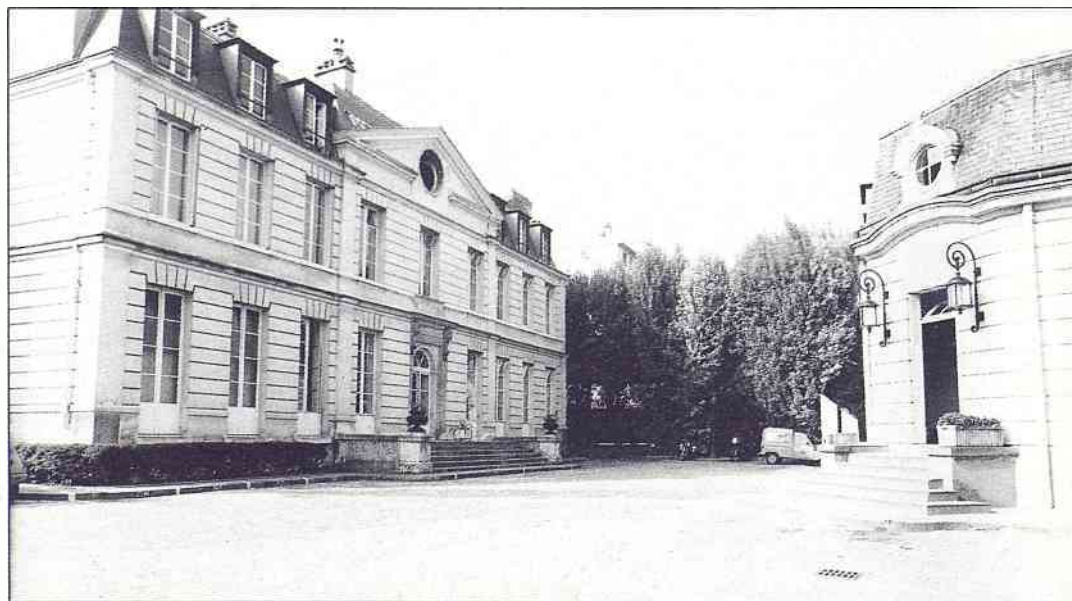
Façade sur les jardins du Château de l'Amiral, occupé par le Gaz de France, telle qu'on peut la voir de la rue de Fontenay.
